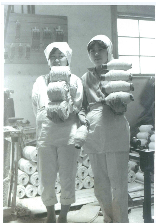
屈託もなく石綿製品を手に微笑む石綿労働者たち。この写真に示されるように、石綿の危険性や、ばく露防止の教育は行われませんでした。国は規制せず、これが泉南の石綿工場の普通の光景でした。
